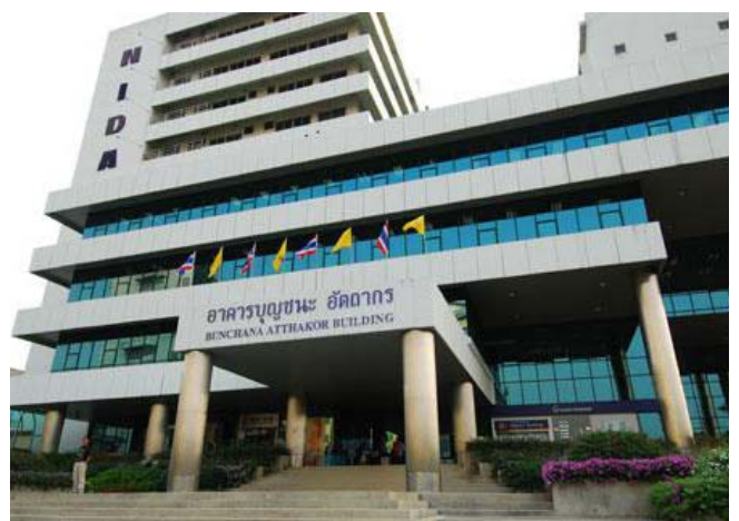
พ.ศ.2541-2553 อาคารบุญชนะ ภัตตาคาร ชั้น 2-4
